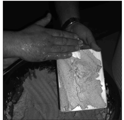
Mörtel auf den Schamottefutterstein auftragen.
