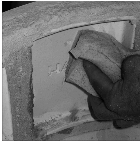
Kachelring innen mit einem Schwamm anfeuchten.
