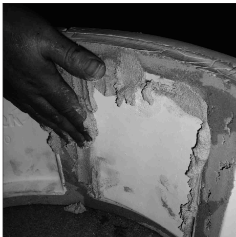
Die Spalten mit Mörtel auffüllen.
